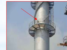
ระบบตรวจวัด Oxygen Analyzer Sensor
