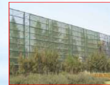
โครงเหล็กติดตั้งตาข่ายล้อมรอบพื้นที่ลานกองขานอ้อย
